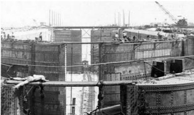
Şekil 40. Panama Kanalı Yapımı
