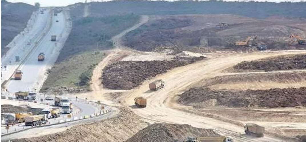
Şekil 42. 3. Havalimanı Şantiye Alanından Bir Görünüm
