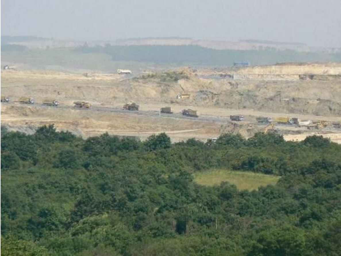
Şekil 7. 3. Havalimanı İnşaat Aşaması Görünümü
