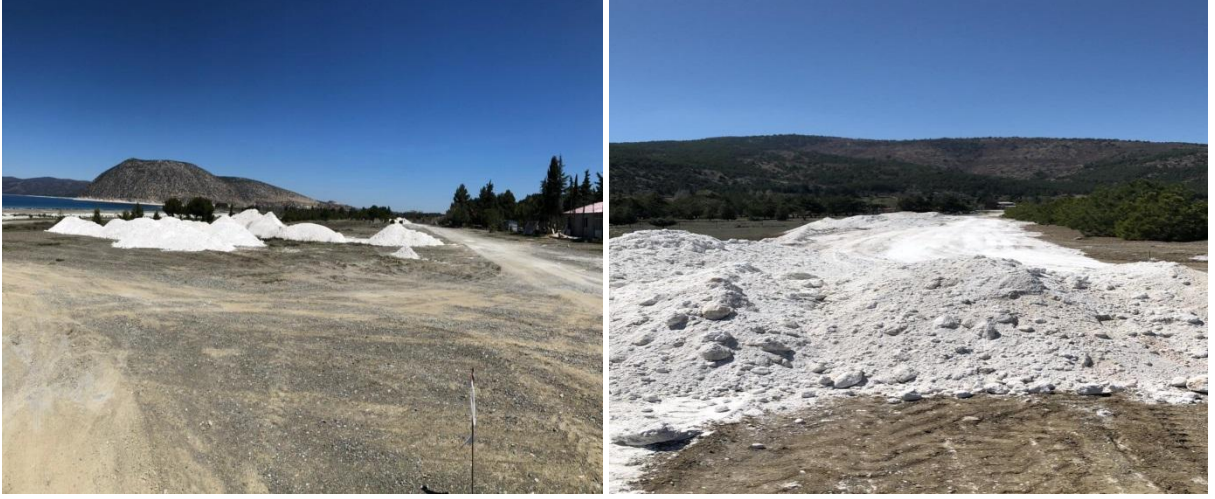
Resim 4a-4b: Sahadaki İnşai Çalışmalar - Hafriyat Malzemesi
