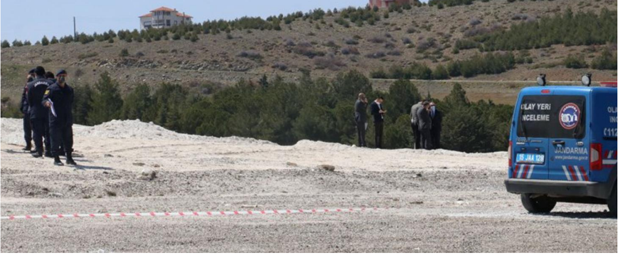
Resim 8: Sahadaki İnşai Çalışmaların Denetlenmesi
