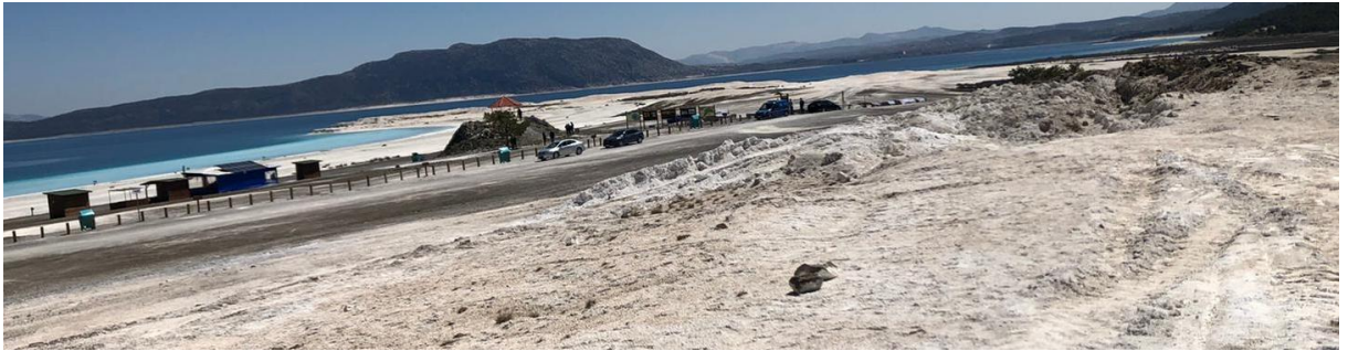
Resim 5: Sahadaki İnşai Çalışmalardan Genel Görünüm 1
