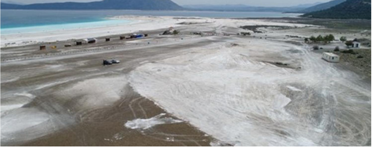
Resim 6: Sahadaki İnşai Çalışmalardan Genel Görünüm 2
