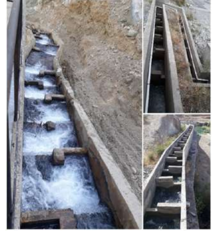
Foto 3: Adıyaman Hidroelektrik Santralleri Balık Geçidi Örnekleri (Adıyaman, 2020, F.A.KAPLAN)
