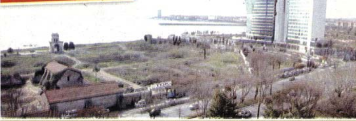
İznin verilmesinin ardından, arazide ağaç katliamına göz yumuldu, ardından inşaat çalışmaları hızla ilerledi.
