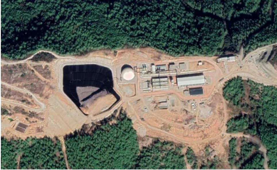
Şekil 9 Alanya entegre atık değerlendirme tesisi
