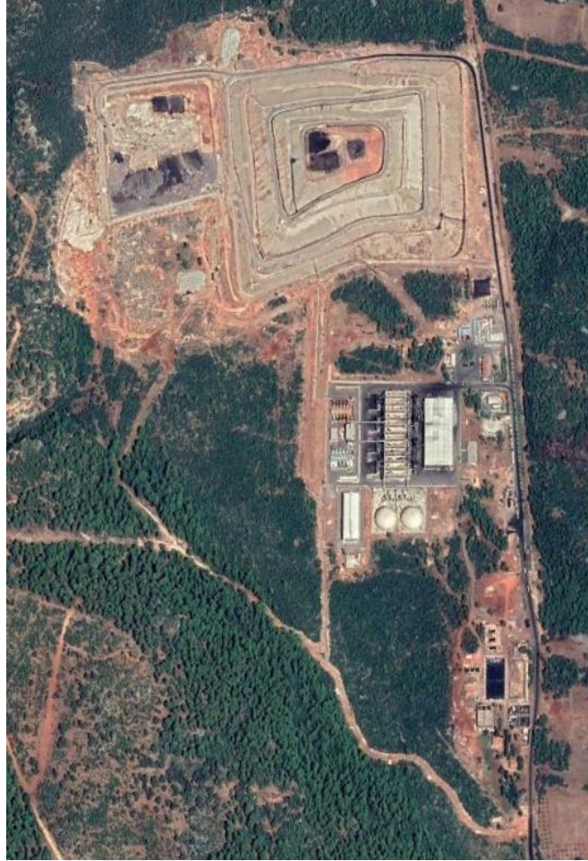
Şekil 8 Kızıllı entegre atık değerlendirme tesisi
